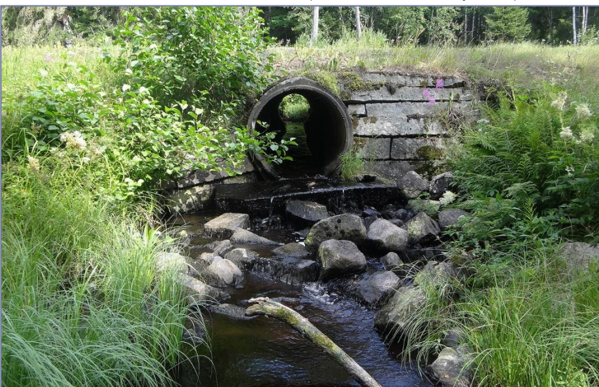
Kuva 5.4. Iso Särkijärvestä Keihäsjärveen laskevan Myllypuron alaosalla Virtaintien tierumpu muodostaa kaloille nousuesteen.
